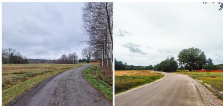
Przebudowa drogi gminnej nr 102324R w miejscowości Stary Nart od km 0+285 do km 0+889
