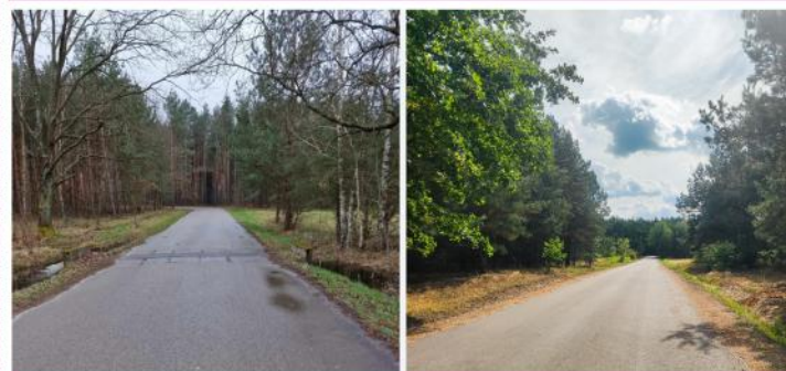
Przebudowa drogi gminnej nr 102314R w miejscowości Krzywdy od km 0+000 do km 0+900
